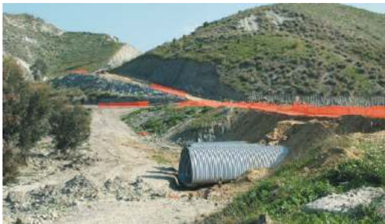
I lavori della strada del mare in località Lenze
